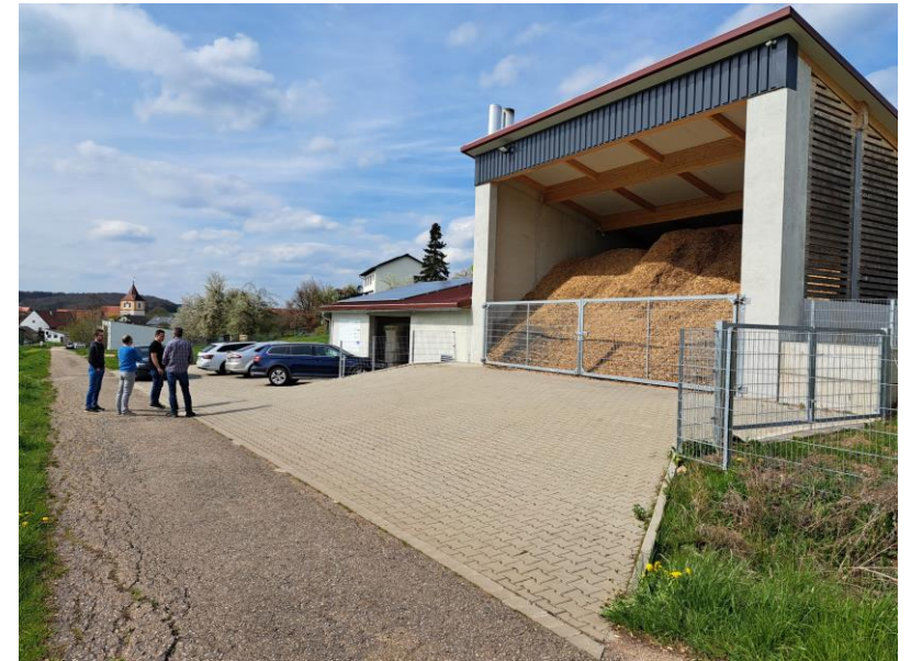
Nahwärme Theilenhofen, Foto AK Solarwärme Bracht
