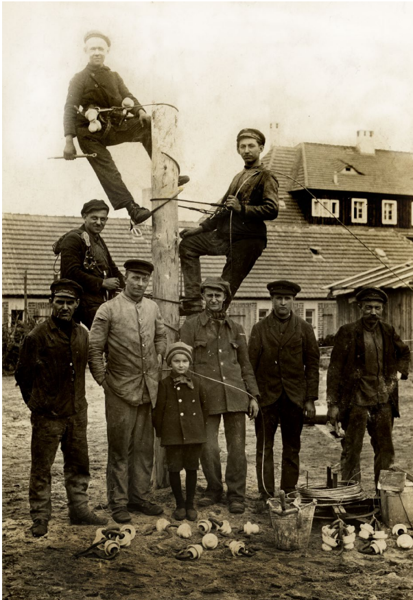
Elektrifizierung in Werminghoff
